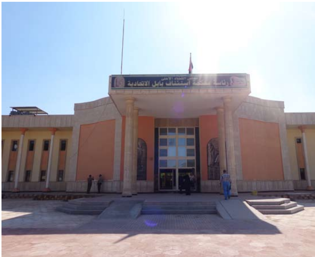
مبنى رئاسة الاستئناف في بابل/ عدسة القضاء
